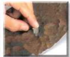
外部腐食がある試験体の測定
