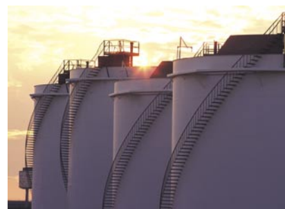
原油貯蔵タンク
